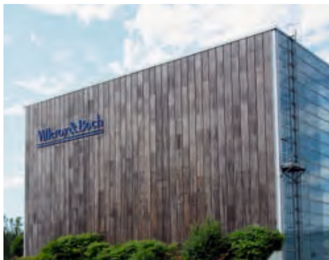
GEWERBEBAU VILLEROY & BOCH, KERTO-FASSADE, KESSELDROCKIMPRÄGNIERT
