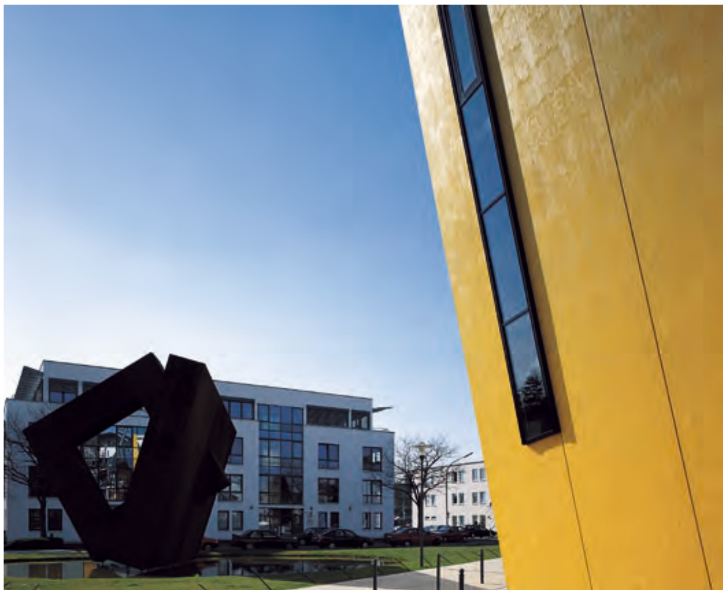
KERTO-FASSADE „FACHHOCHSCHULE JÜLICH“
